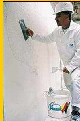
Der Konstruktur-Putz wird auf die Außenfläche aufgetragen.
