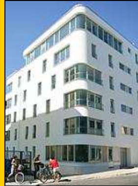
Dieses Ultra-Niedrigenergiehaus in München wurde mit einem Wärmedämm-Verbundsystem auf Basis von Polyurethan-Rohstoffen von Bayer MaterialScience ausgestattet.
