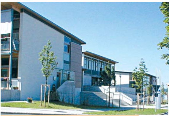
Die integrierte Schule in Gunzenhausen steuert ihre gesamte Gebäudetechnik über ein Automatisierungsnetzwerk
